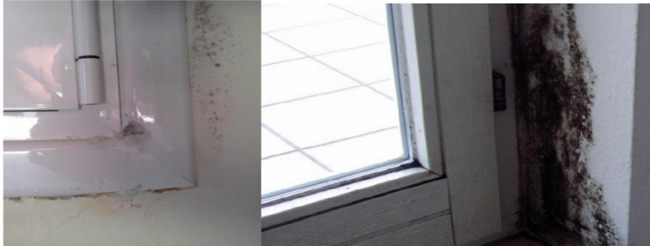
Εικόνα 5.1: Παραδείγματα συνέπειας φθοράς από την εμφάνιση υδρατμών λόγω κακής στεγάνωσης.
