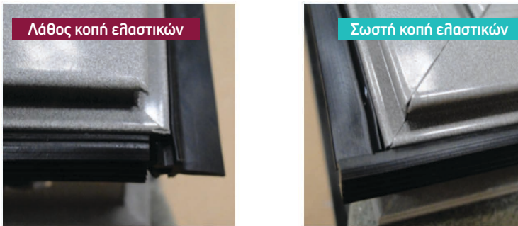
Σχήμα 2.2.6: Έλεγχος κοπής ελαστικών
