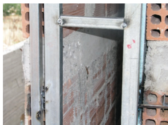
Σχήμα 3.2.1: Τοποθετημένη ψευτόκασα
