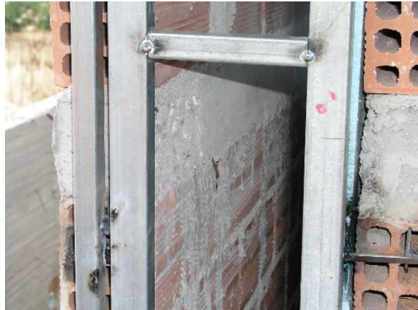
Σχήμα 2.3.1. Τοποθετημένη ψευτόκασα
