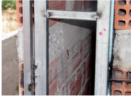
Φωτογραφία 10.1. Τοποθετημένη ψευτόκασσα
