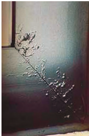
Φωτογραφία 4.1. Παράδειγμα νηματοειδούς διάβρωσης στα φάλτσα κουφώματος αλουμινίου
